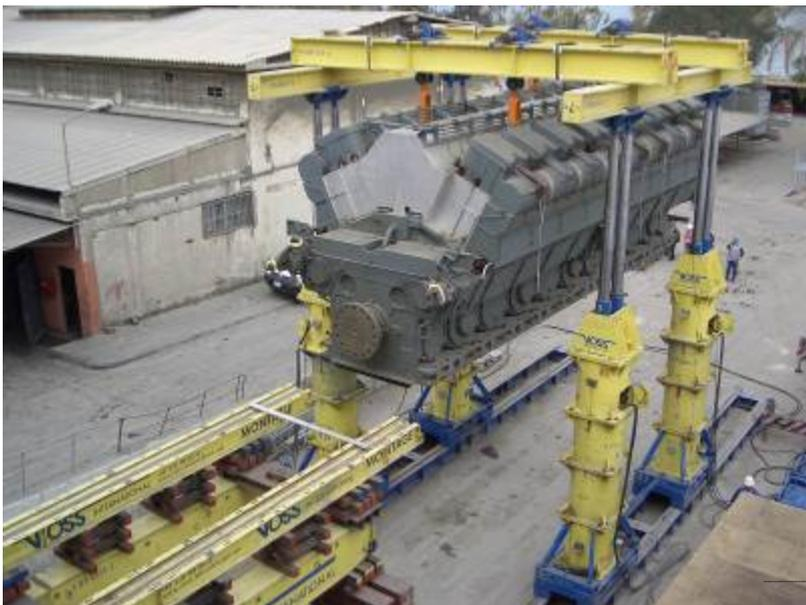
Einbringung eines Dieselmotors 280 tons im Kraftwerk in Chekka, Libanon
