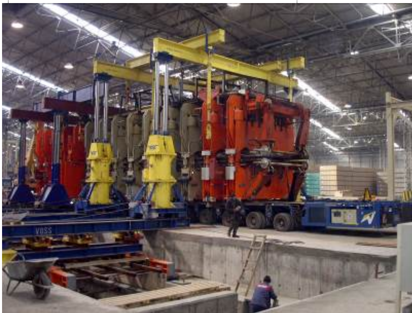
Spanplattenpresse in RO-Sebes Heben aus Grube und seitliches Verfahren von 14 Pressensegmenten, Gewicht 480 tons Einsatz von 8 Hubeinheiten mit Synchron-Hub
